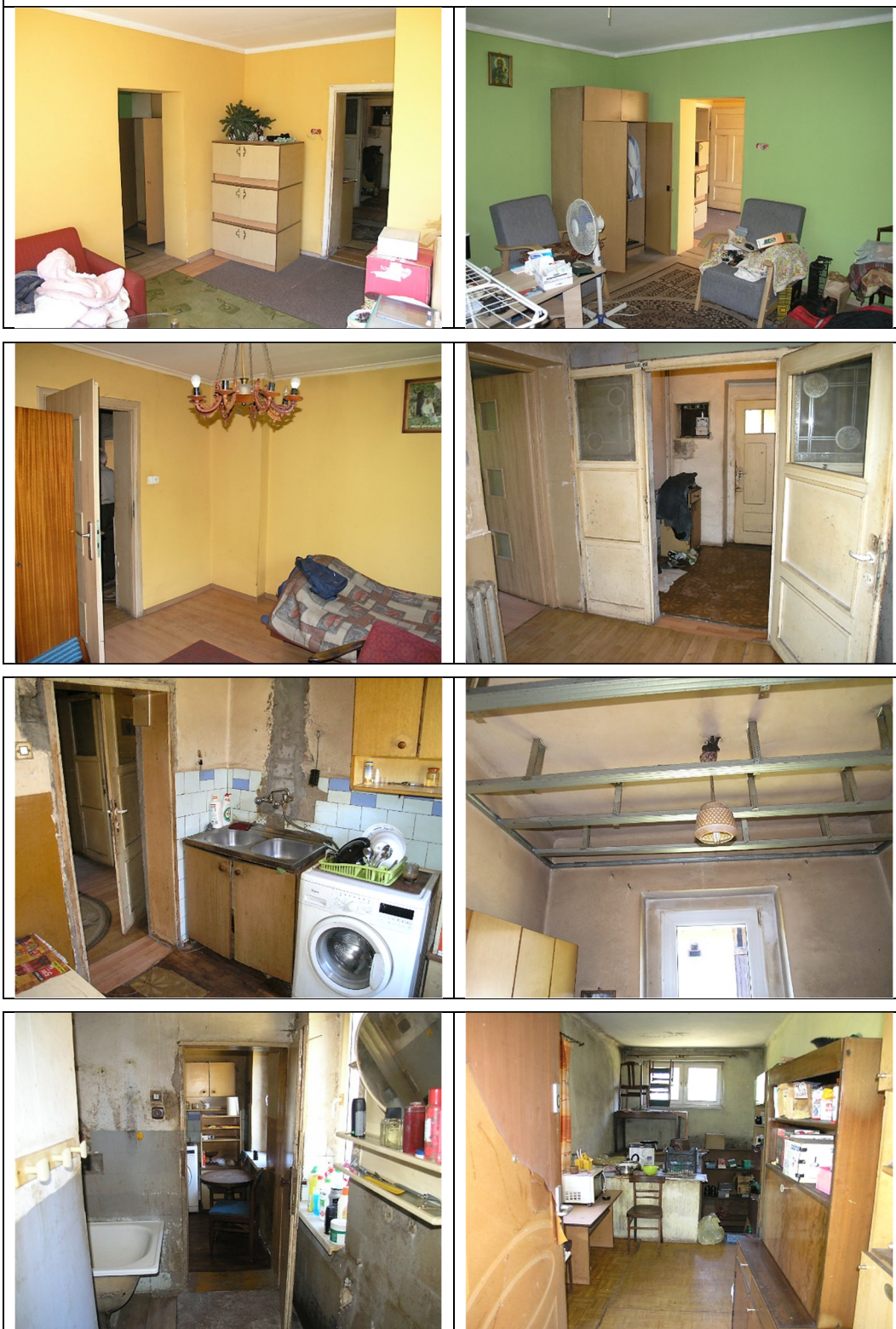
Stan techniczny i wykończenia budynku nr 19 - PARTER
