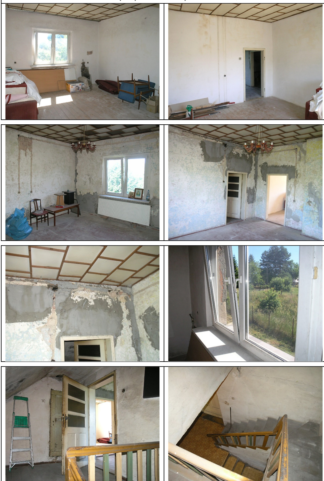
Stan techniczny i wykończenia budynku nr 19 - PIĘTRO
