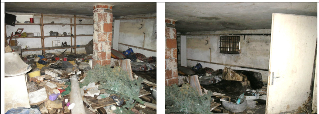
Stan wykończenia wewnętrznego - PIWNICE
