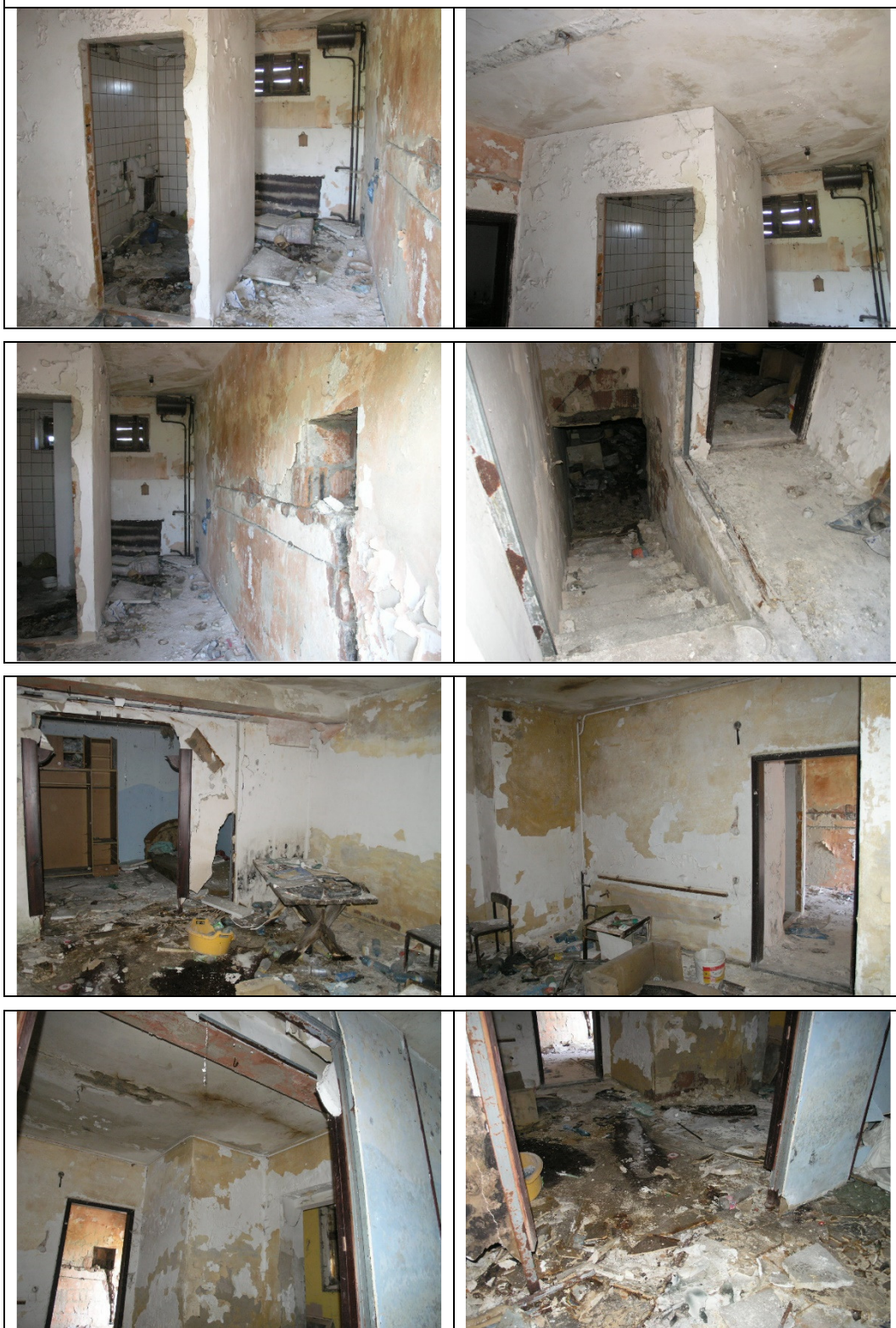
Stan wykończenia wewnętrznego - PARTER
